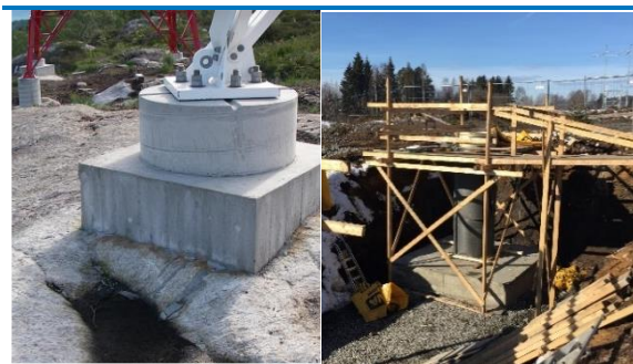
Figur 2-1. Eksempler på fjellfundament (venstre) og jordfundament (høyre).
